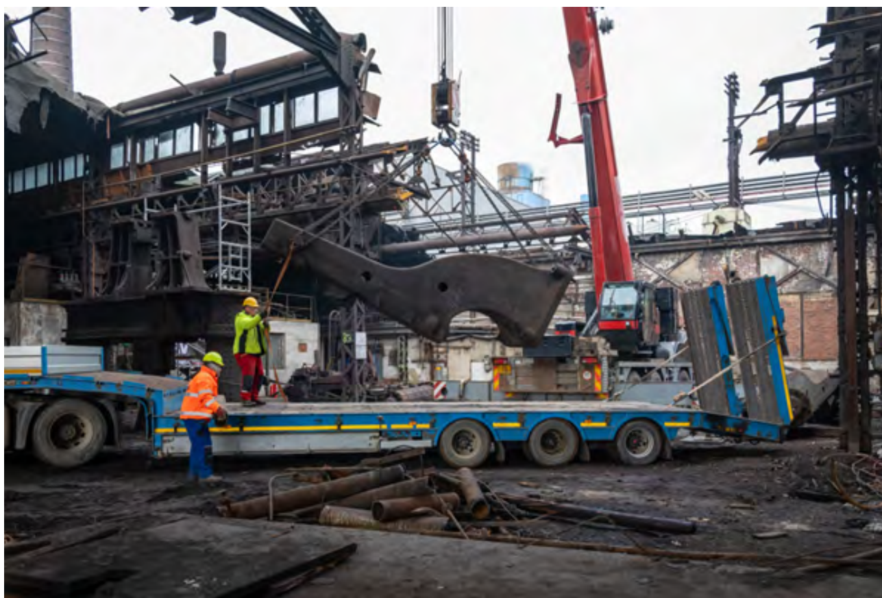
Demontáž a transfer parního bucharu
